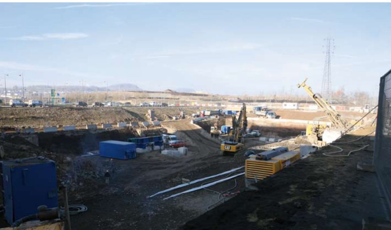
Préparations pour la construction des fondations de la Maison des Sciences Humaines
