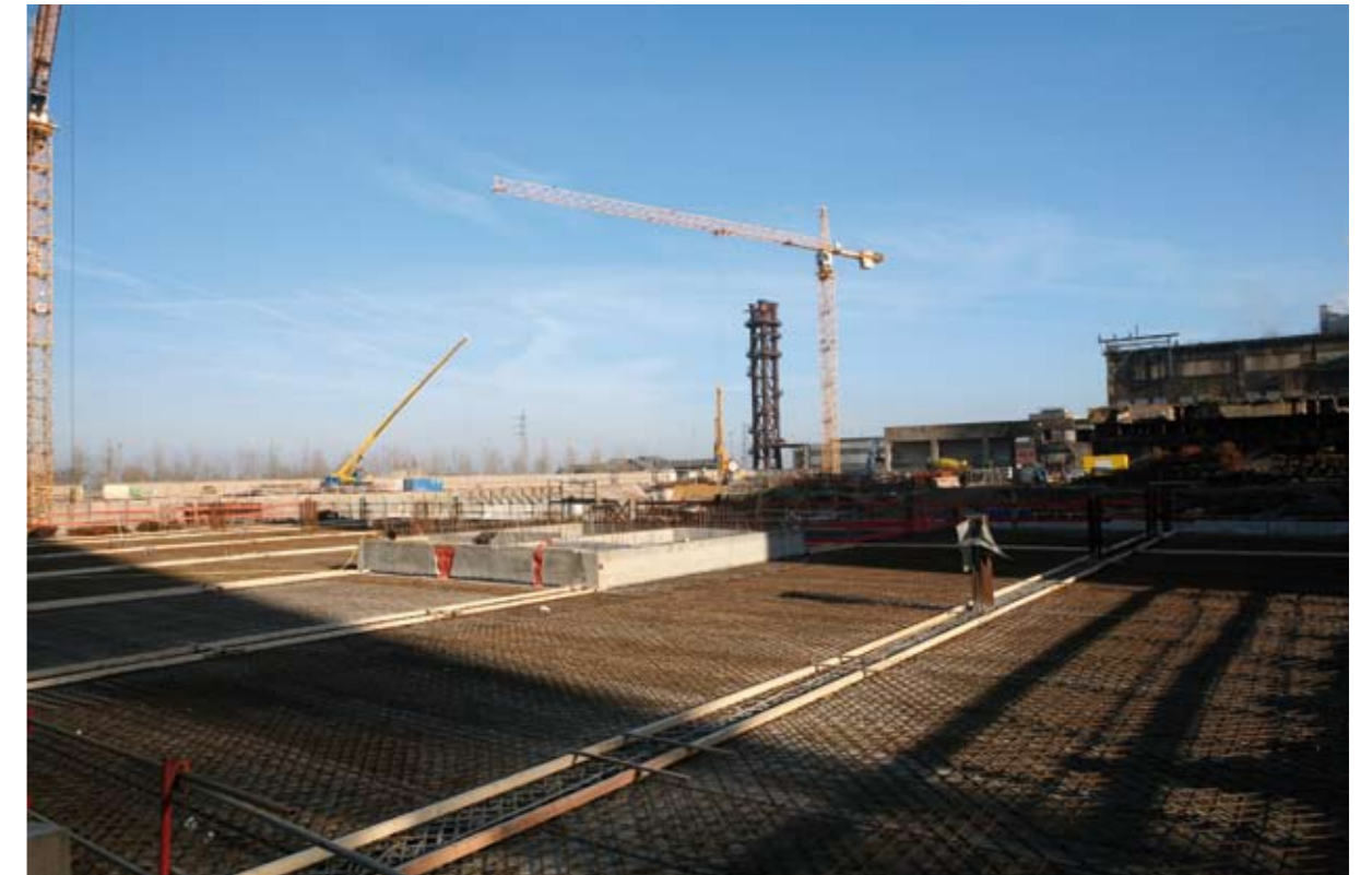
Réalisation du parking de la Maison du Savoir
