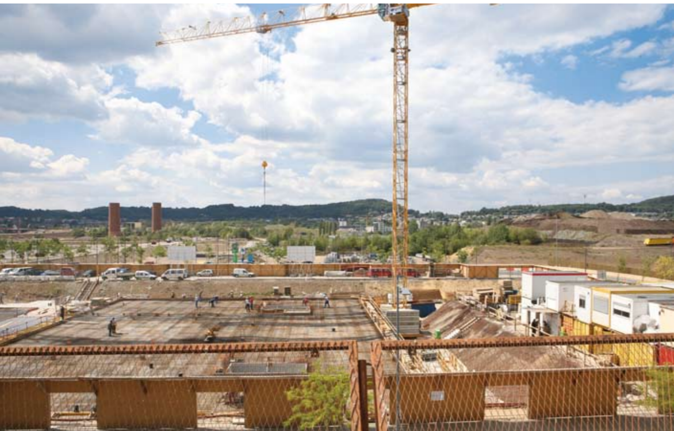
Le chantier de la Maison des Sciences Humaines
