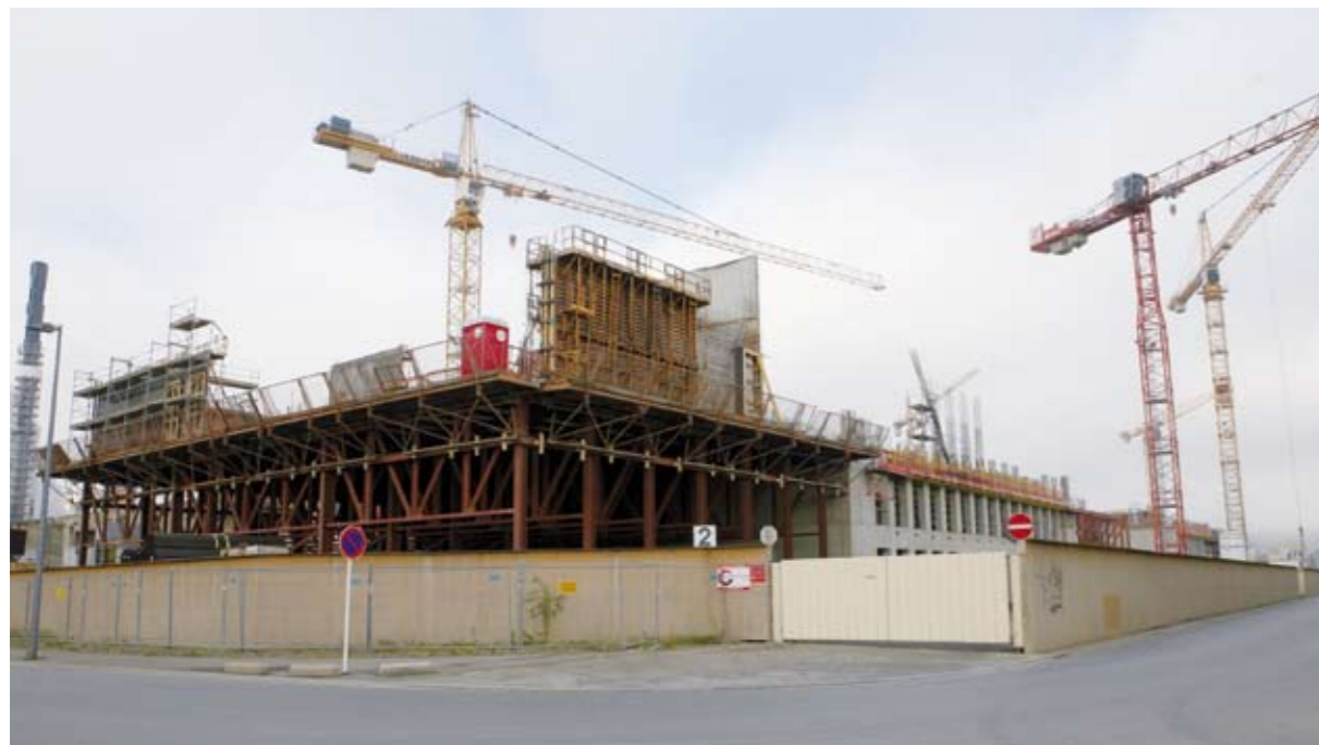
Supports métalliques des porte-à-faux
