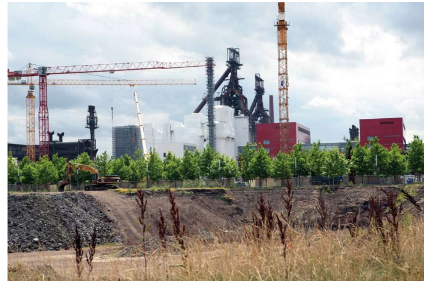
Chantiers sur la Terrasse des Hauts Fourneaux
