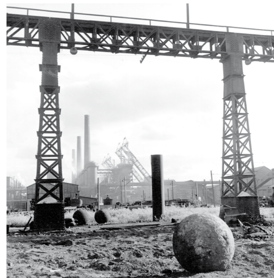
Vue des hauts fourneaux de Belval en 1958 avec boules casse-fonte © Photothèque de la Ville de Luxembourg, collection Marcel Schroeder
