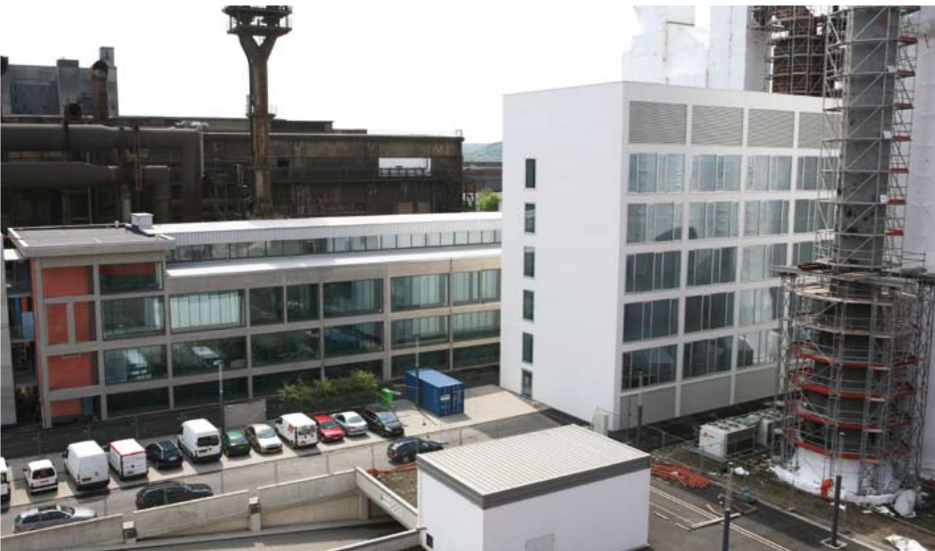
A gauche l'Incubateur d'entreprises, à droite le bâtiment Biotech
