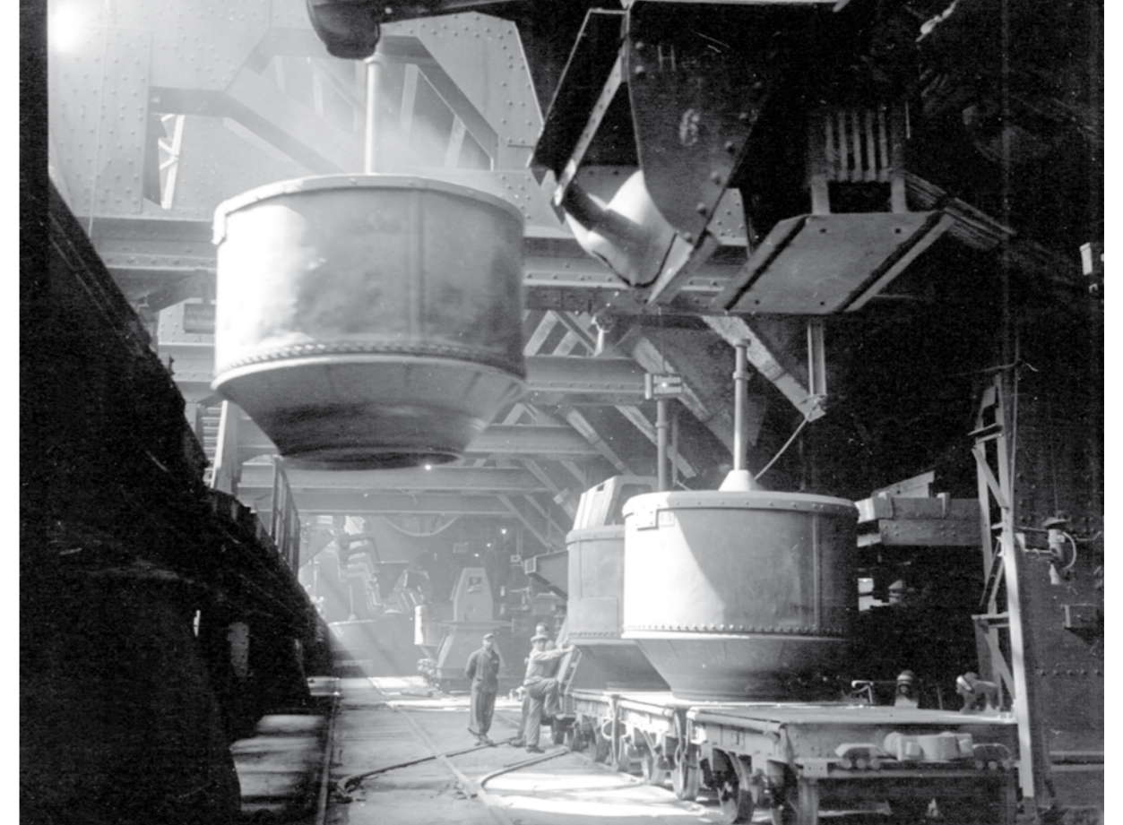
Monte-charges et «bennes Stähler» © Photothèque de la Ville de Luxembourg, collection Marcel Schroeder
