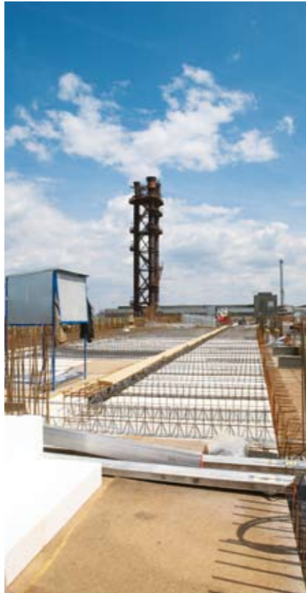
Le chantier de la Maison du Savoir
