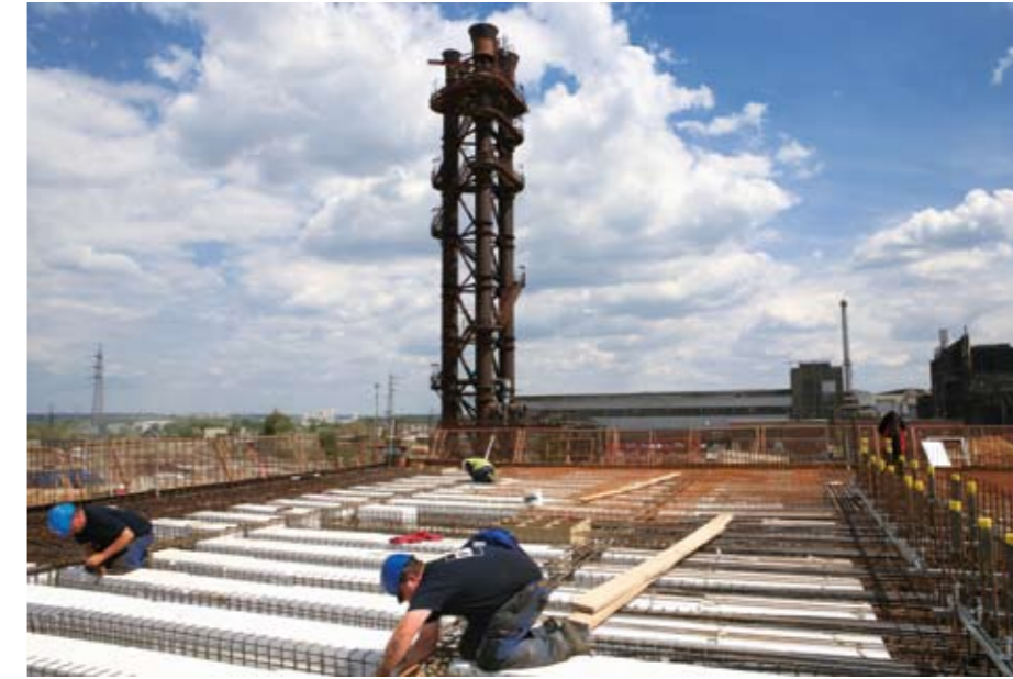
Pose d'une couche d'isolation sur la barre
