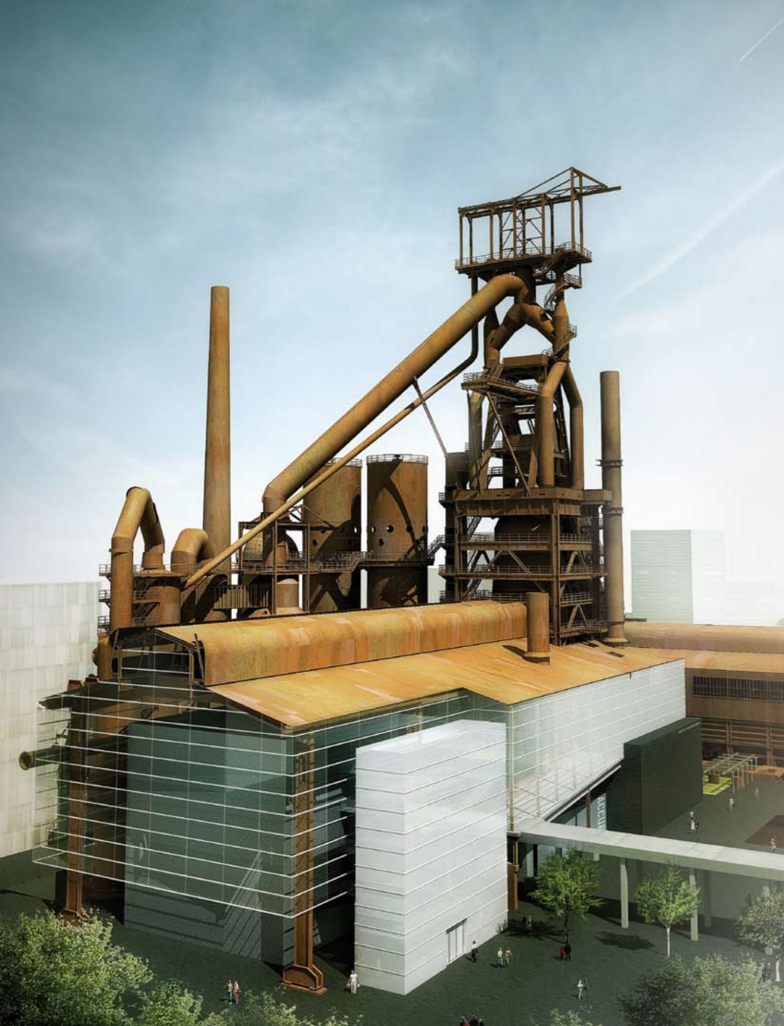
Vue sur le haut fourneau A restructuré
