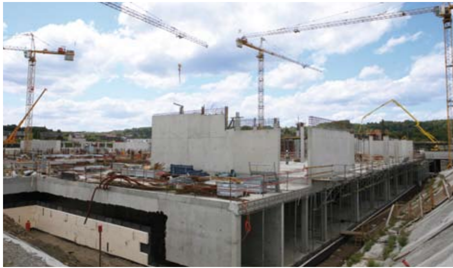
Le chantier du Lycée Belval ne rencontre pas les contraintes des projets situés sur la Terrasse des Hauts Fourneaux
