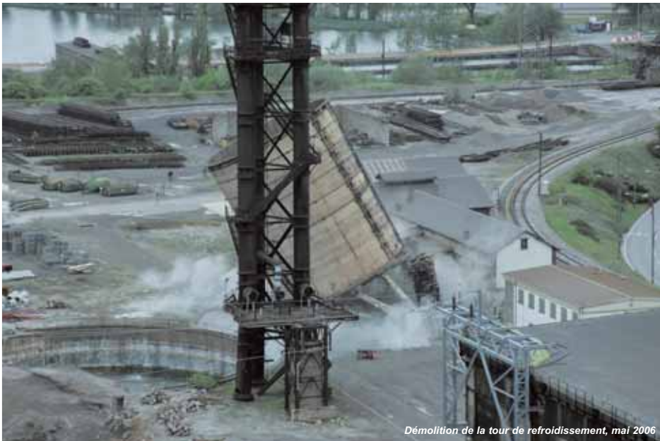
Démolition de la tour de refroidissement, mai 2006
