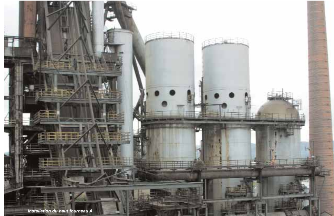
Installation du haut fourneau A
