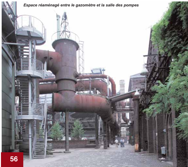
Espace réaménagé entre le gazomètre et la salle des pompes
