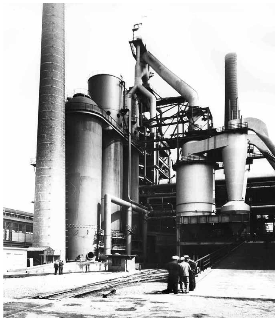
vue du haut fourneau juste avant sa mise en service en 1966. au premier plan les 3 cowpers et la cheminée. à droite l'épuration des gaz.
