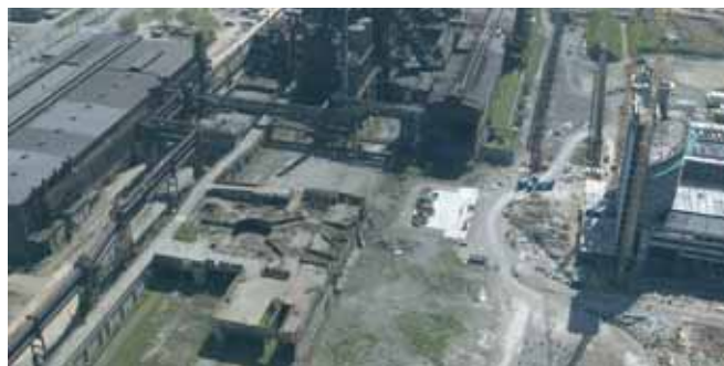
les fondations du C à Belval
