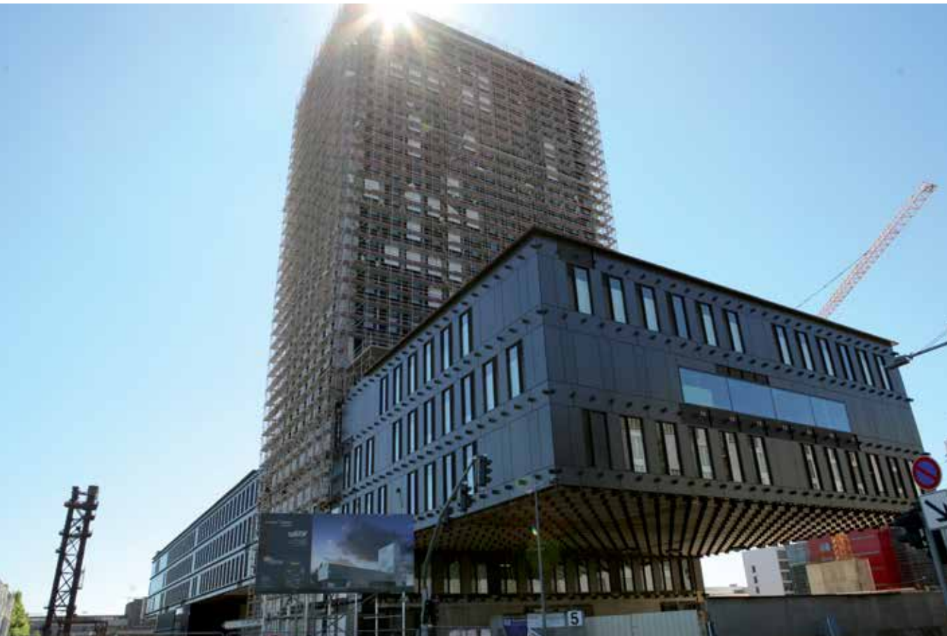
Le socle, la barre et la tour de la Maison du Savoir
