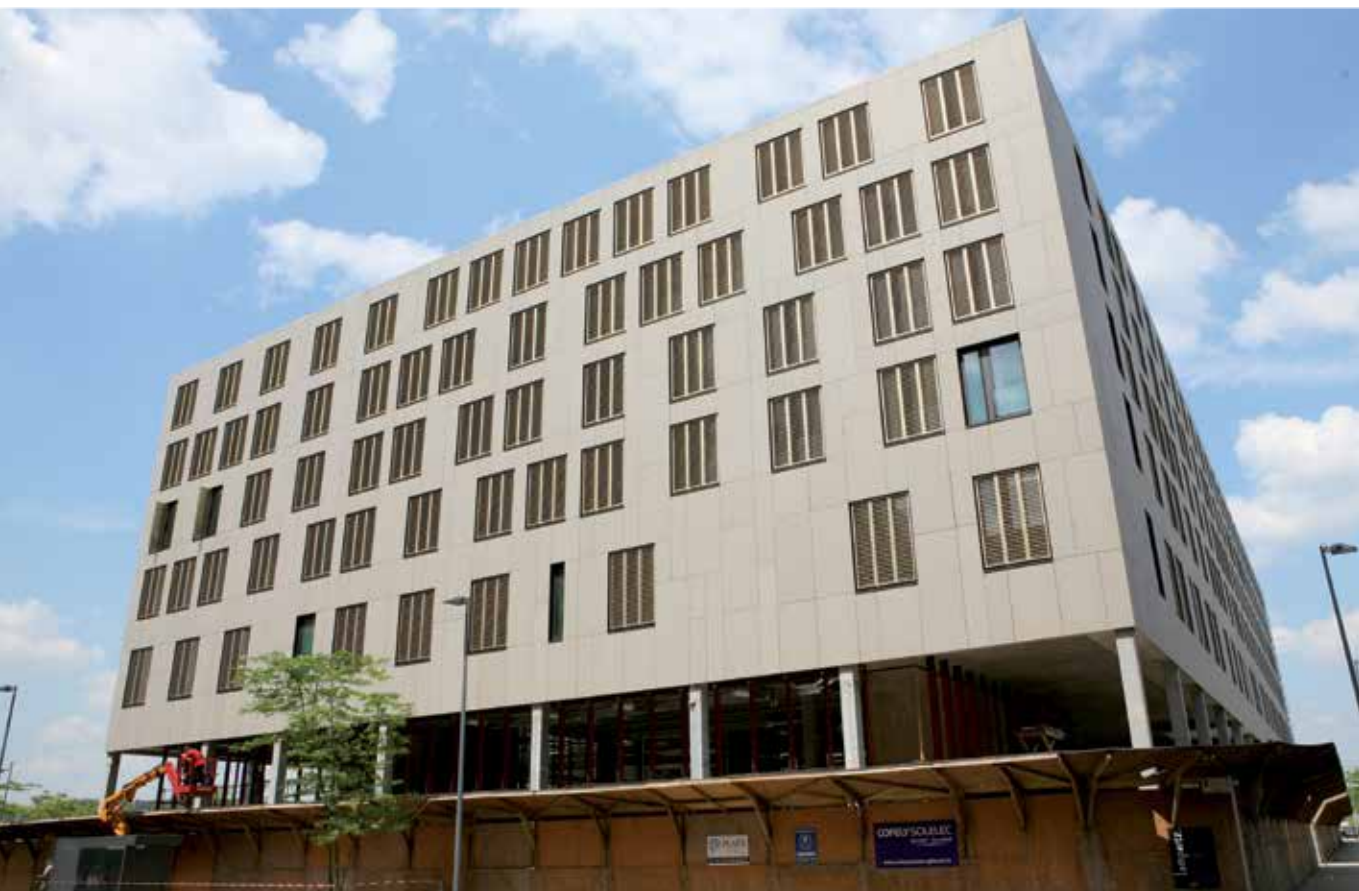
La façade Sud de la Maison des Sciences Humaines
