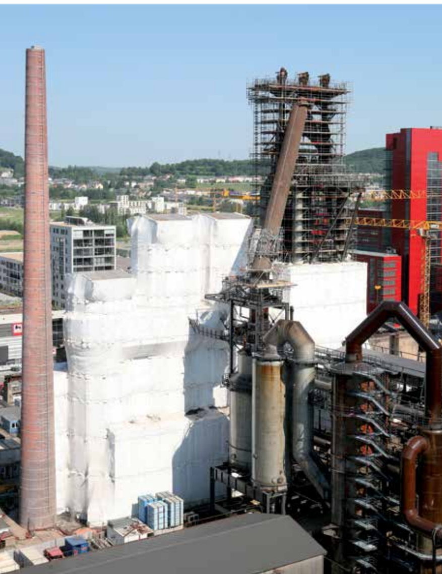
Le haut fourneau A en cours de traitement
