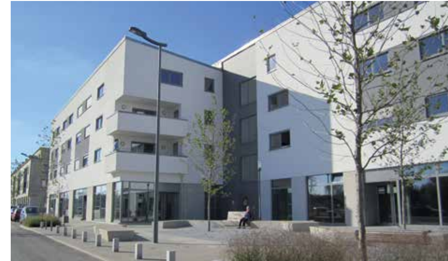
Logements étudiants dans le nouveau quartier Nonnewisen à Esch-sur-Alzette
